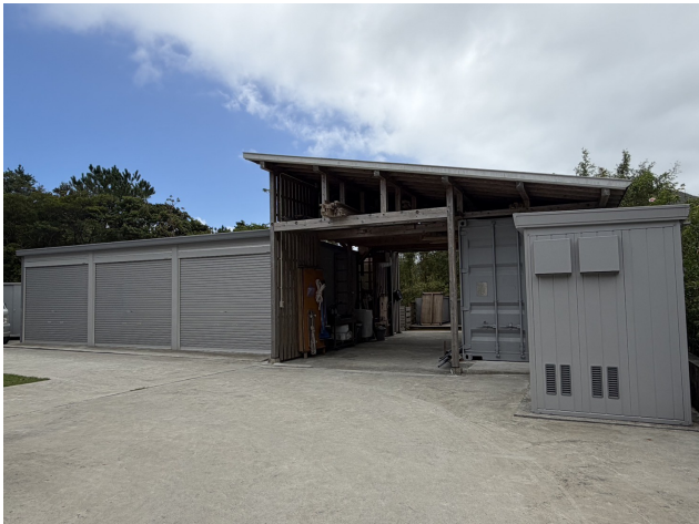
敷地 倉庫まわりの全景
